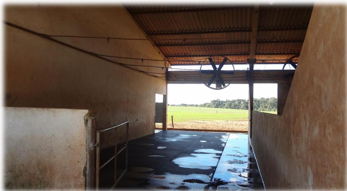
**Figura 11: Sala de espera com seus ventiladores e aspersores.**
