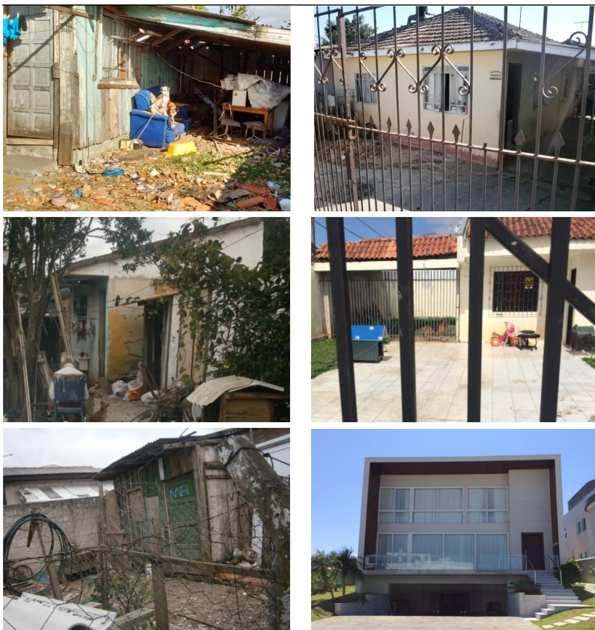
FIGURA 8. ILUSTRAÇÃO COMPARATIVA DE MORADIAS COM (A) E SEM (B) DESORGANIZAÇÃO E DESCUIDO NA MANUTENÇÃO PREDIAL IDENTIFICADAS DURANTE AS VISTORIAS DE MAUS-TRATOS AOS ANIMAIS REALIZADAS PELA SEÇÃO DE DEFESA E PROTEÇÃO ANIMAL (SEDEA) DE PINHAIS, PR.
